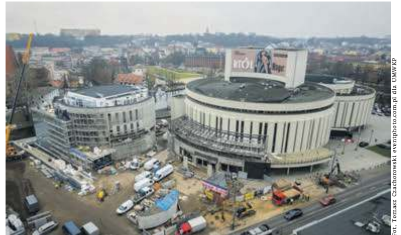
Budowa czwartego kręgu Opery Nova w Bydgoszczy
