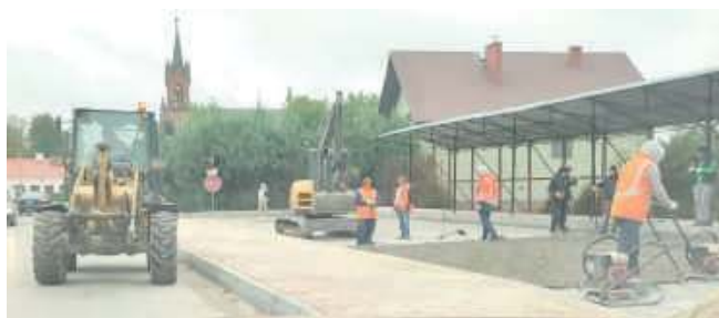
Remont drogi w Komarówce Podlaskiej ma się zakończyć w połowie listopada
