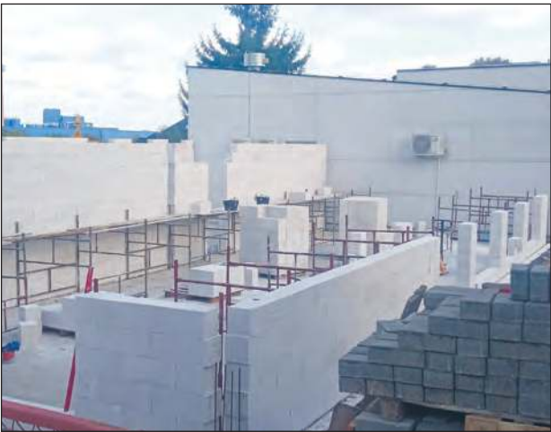
Prace przy rozbudowie żłobka rozpoczęły się w trzeciej dekadzie października. Do wiosny budynek powinien być wykończony i wyposażony
