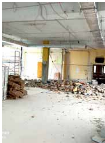
W środku prowadzona jest rozbiórka ścian – konieczna do zupełnie nowej aranżacji wnętrza
