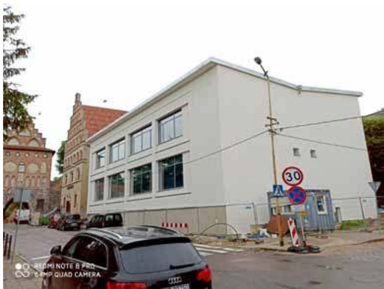
Prace przy elewacji nowego budynku są już prawie skończone
