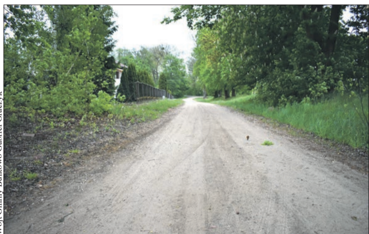
Droga gminną nr 290424W czeka przebudowa
