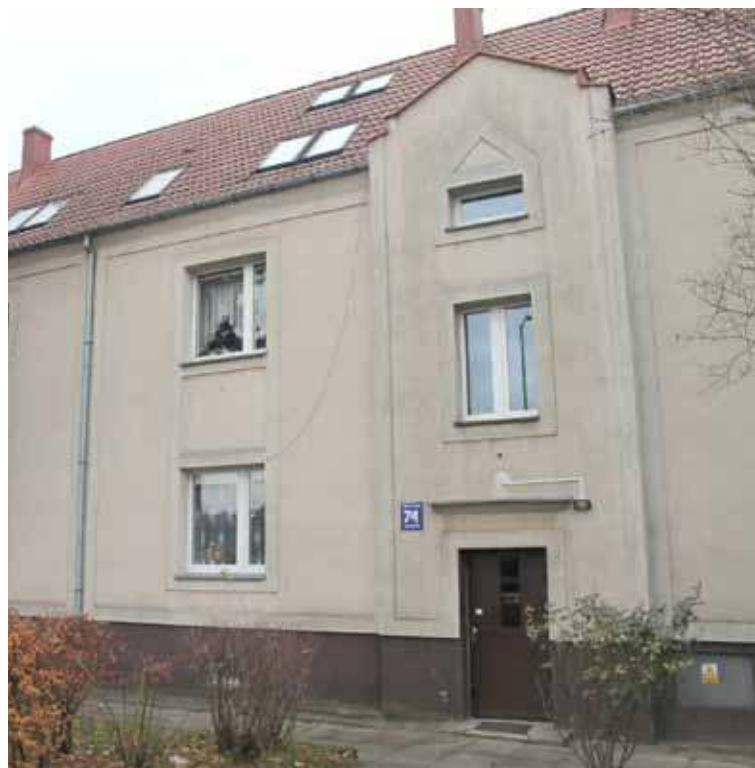
W kamienicy na Kościuszki 74-76 w piątek, sobotę i niedzielę rano, do momentu naprawy instalacji gazowej, mieszkańcy marzli i nie mieli ciepłej wody
