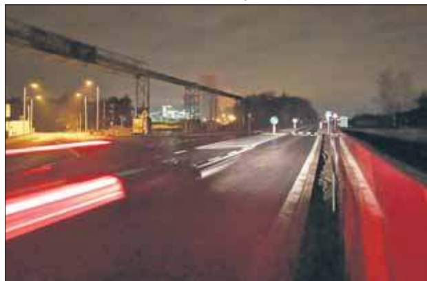
Łączny koszt przebudowy ul. Martyniaków to 8,4 mln zł
