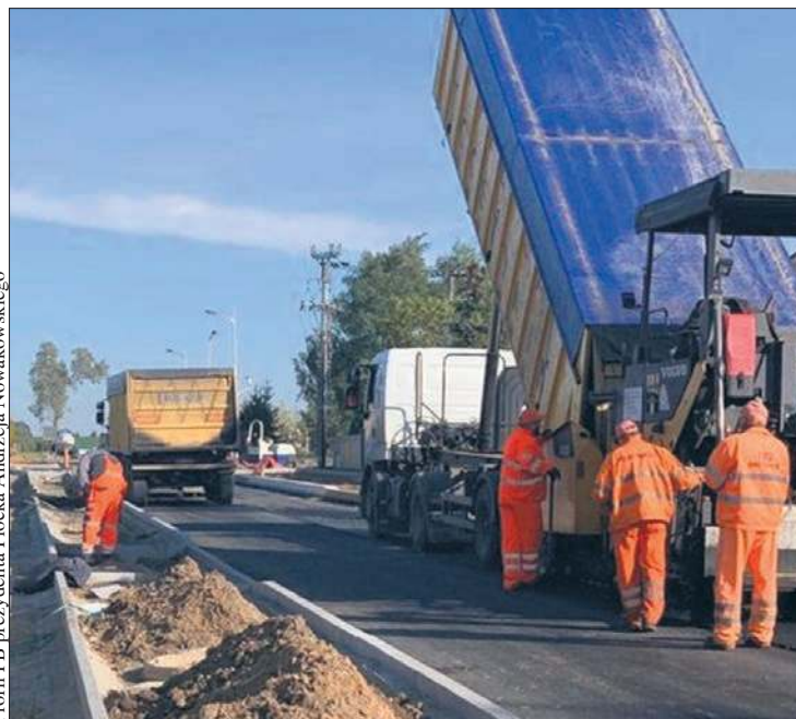
W ubiegłym tygodniu na ulicy Parcele drogowcy układali asfalt
