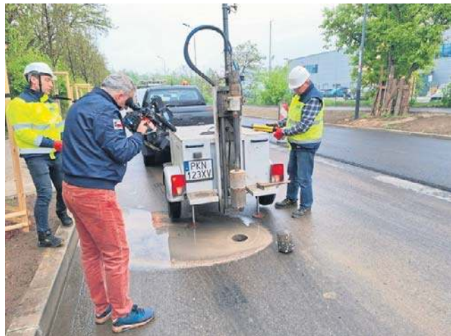
Remont Szparagowej zbliża się do mety. Ulica ma nowe lokalizacje przystanków, nową jezdnię i porządne chodniki
