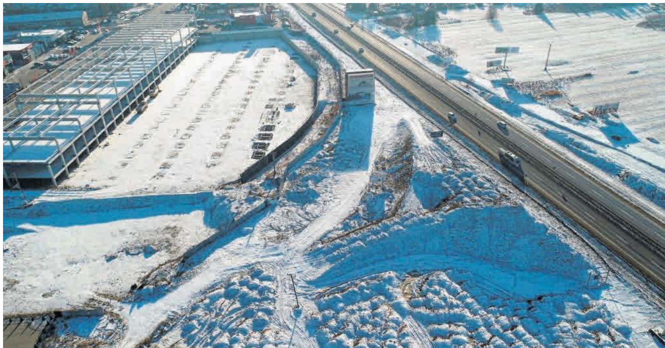
Plac budowy węzła Nowy Targ południe, który bez dodatkowych inwestycji nie byłby w pełni funkcjonalny
