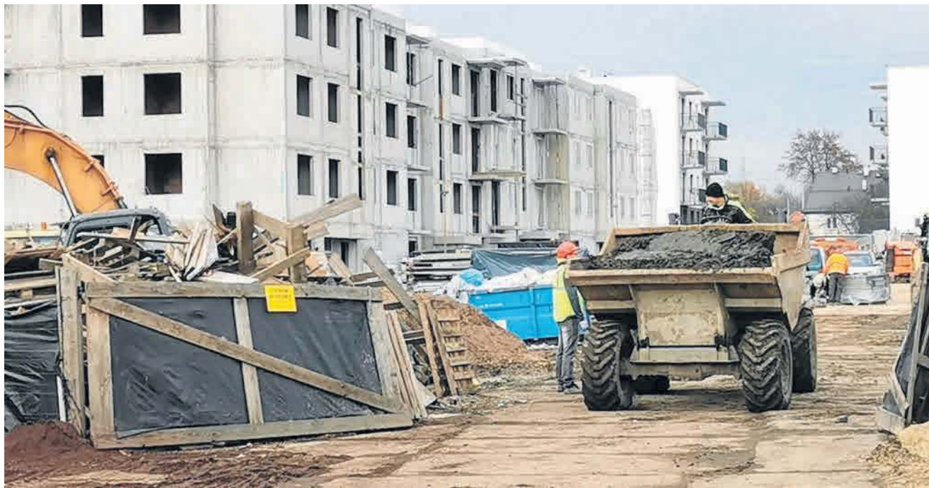
Trwa budowa osiedla Chrzanowskie Błonia. W pięciu trzypiętrowych blokach mieści się 176 mieszkań
