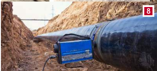
5. Wczesne ręcznie układane rurociągi; 6. Elektryczne łukowe spawanie rurociągu; 7. Operacja Pluto – układanie rur do ropociągu na dnie kanału La Manche rozwijanych z pływającego na morzu bębna; 8. Inspekcja radiograficzna; 9. Wizualizacja jednego z rodzajów urządzenia typu smart pig
