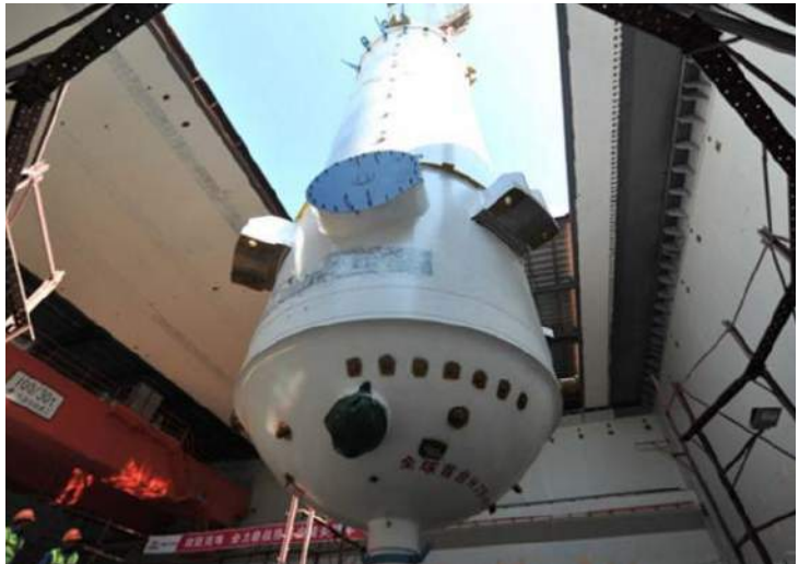
2. Instalacja komory chińskiego reaktora HTR-PM
