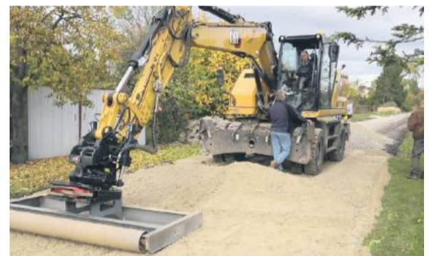
Trwają prace związane z remontem ul. Ogrodowej w Kondratowicach
