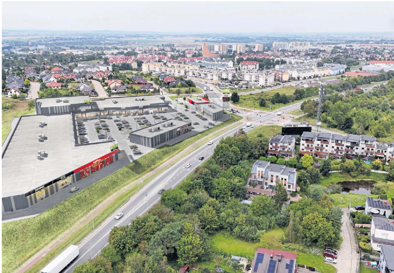
Odzwierciedleniem tczewskiej inwestycji są ogólnokrajowe trendy, w których dominują parki handlowe
