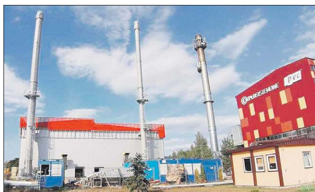
Jak informuje NIK nieprawidłowości dotyczyły budowy ciepłowni opalanej biomasa. PEC Biała Podlaska nie naliczyło wykonawcy kar umownych w kwocie ponad 6,5 mln zł
