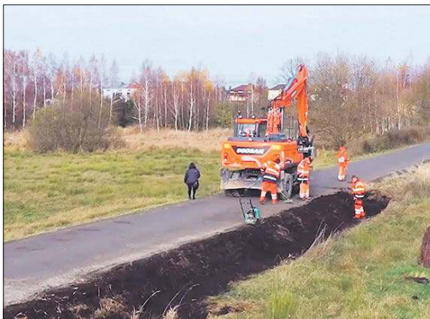
W przeciągu miesiąca prace na ścieżce rowerowej wzdłuż Krzny, po zachodniej stronie miasta, będą zakończone
