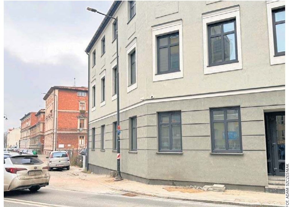
Latarnia została przesunięta o kilka metrów za budynek, skończyły się więc utrudnienia dla pieszych i kierowców
