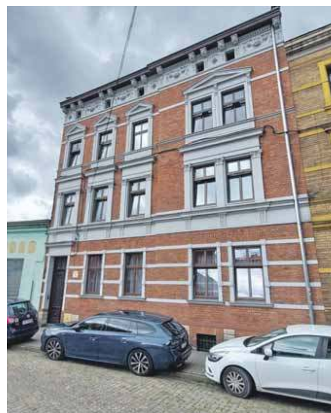
W kamienicy ma zostać zmodernizowana instalacja grzewcza
