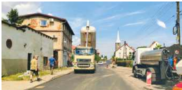
W ubiegłym tygodniu zakończono kolejny etap inwestycji, wylewając nową nawierzchnię asfaltową na głównej drodze w Jegłowej
