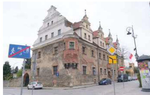
Częściowy remont dachu ma zostać wykonany do końca bieżącego roku
