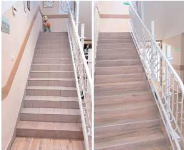
Po lewej schody przed remontem, po prawej już z antypoślizgową nawierzchnią
