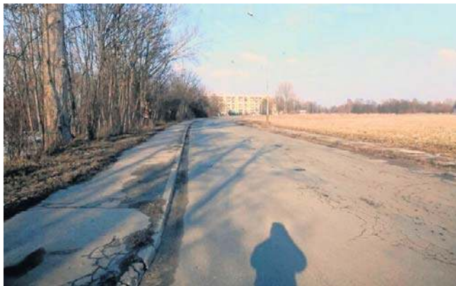
W br. będzie wyremontowana ul. Nowodworska od skrzyżowania z Jaworzyńską do granicy miasta
