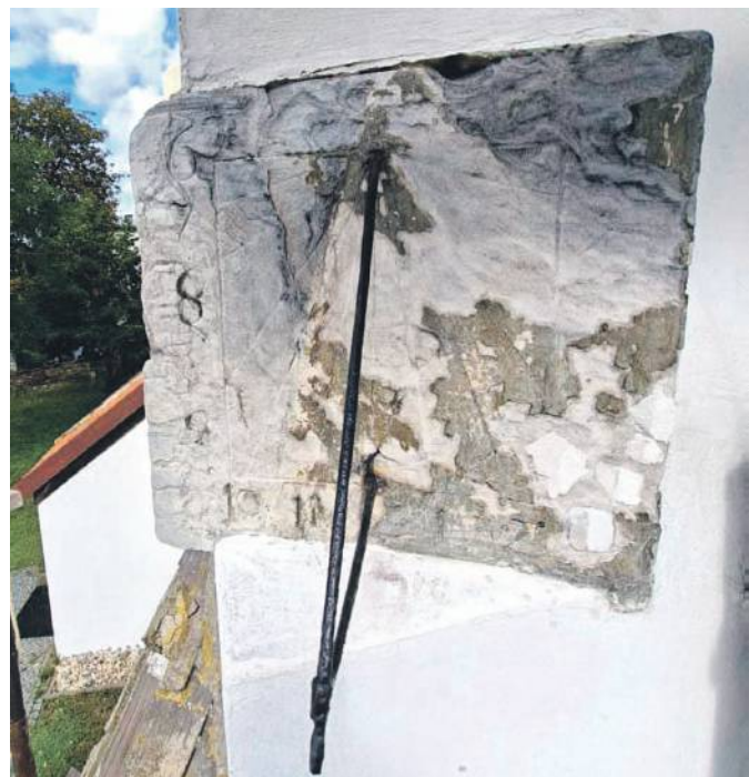
Zegar w Godzikowicach - stan sprzed renowacji
