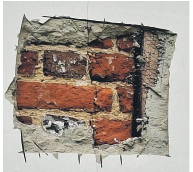
Odkrywką na wschodniej ścianie kościoła w Godzikowicach zachowała pomiędzy ceglami widoczny fragment drewnianej belki. Być może zatem XVIII wieku przy okazji powiększania połaci dachu kościół mógł być wtórnie rozbudowany
