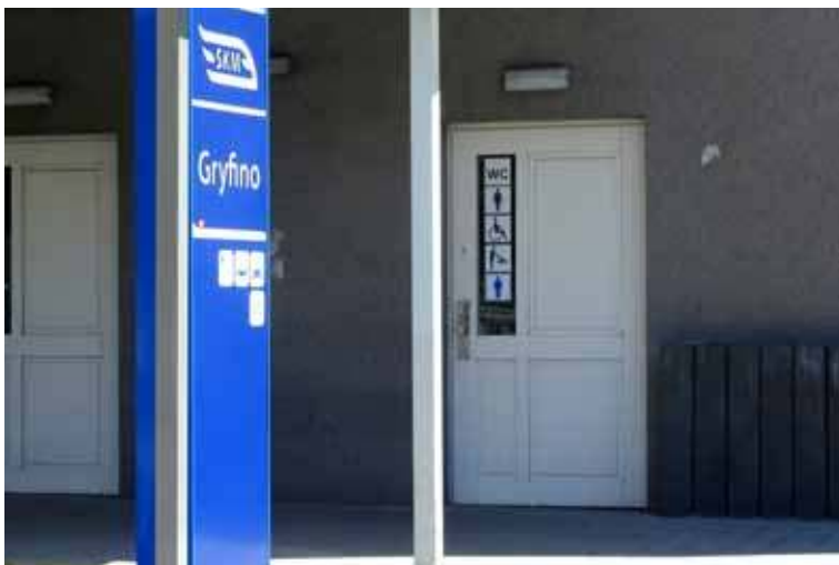
Toaleta na dworcu wciąż nieczynna
