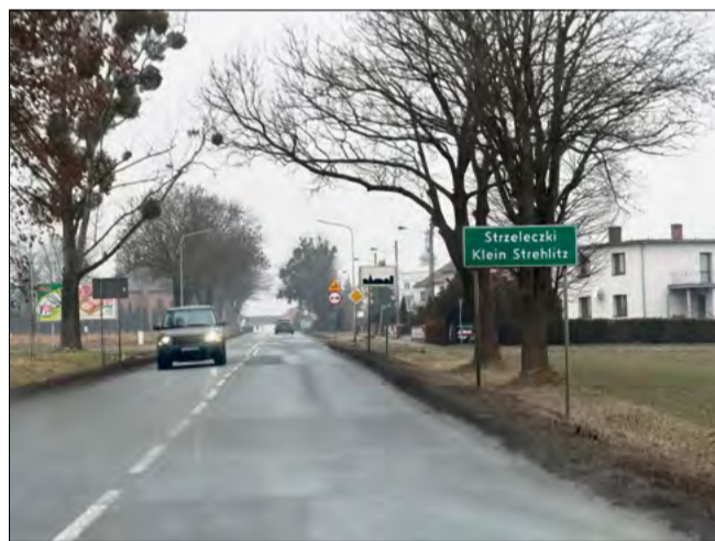
Droga wojewódzka 409 przed remontem.
