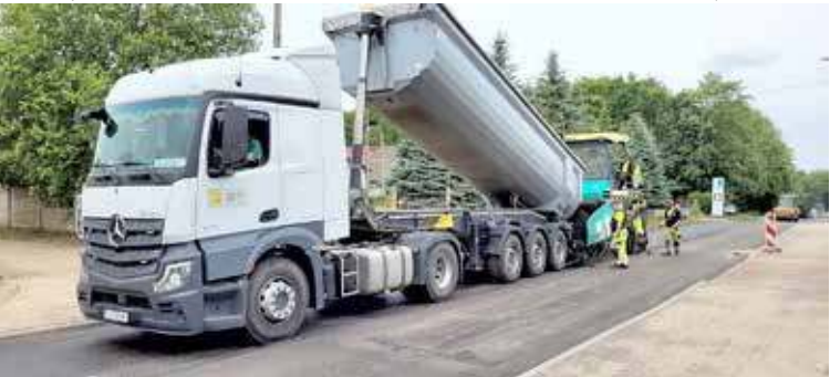
Prace prowadzone przez firmę PRD Nowogard
