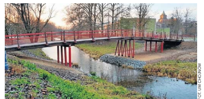
Nawierzchnia powstanie z desek kompozytowych
