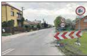
Dzięki wspólnej inwestycji gminy i powiatu już niedługo, ul. Brzeska będzie odnowiona
