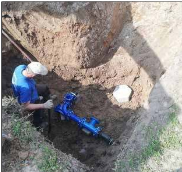
Trwają prace związane z modernizacją sieci wodociągowej na terenie całej gminy
