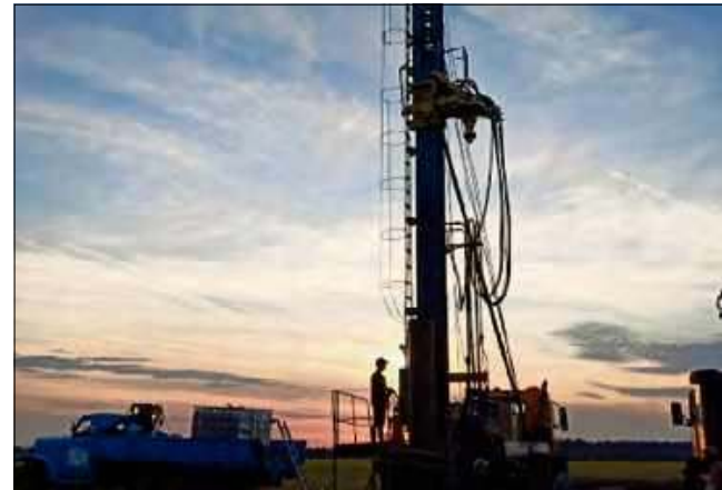
Budowa Stacji Uzdatniania Wody w Dziedzicach. Wartość zadania: 8 023 691,39 zł.
