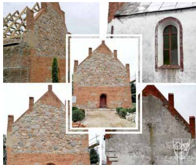
Elewacja ścian zachodniej została odnowiona, ponadto naprawiono więźbę dachu
