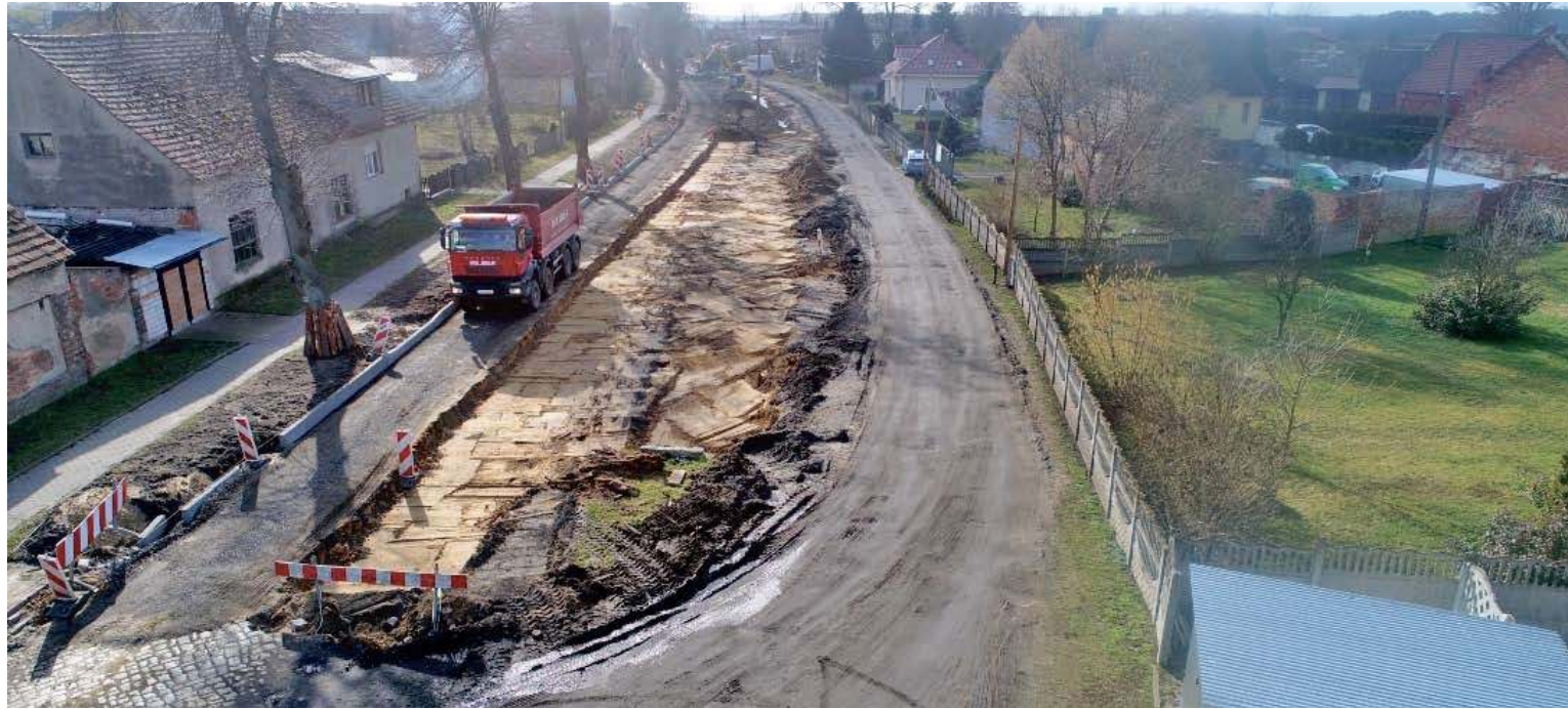
Niedoradz, marzec 2023. Budowa ścieżki z lotu ptaka (mat. powiat nowosolski)
