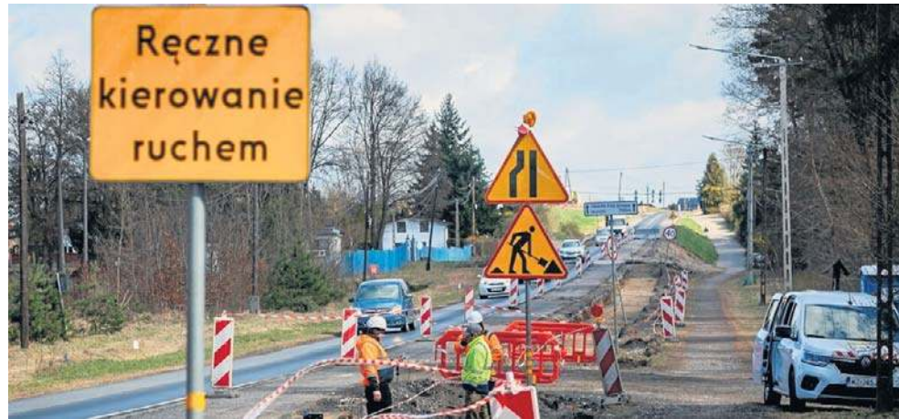
W Żołędowie trwa modernizacja drogi wojewódzkiej nr 244
