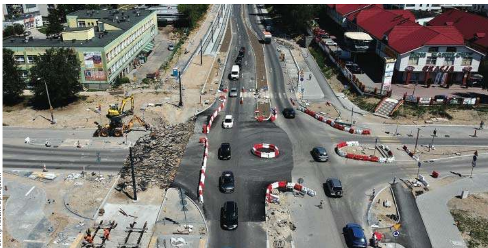
Ulica Wyszyńskiego jeszcze w trakcie budowy nowej linii tramwajowej
