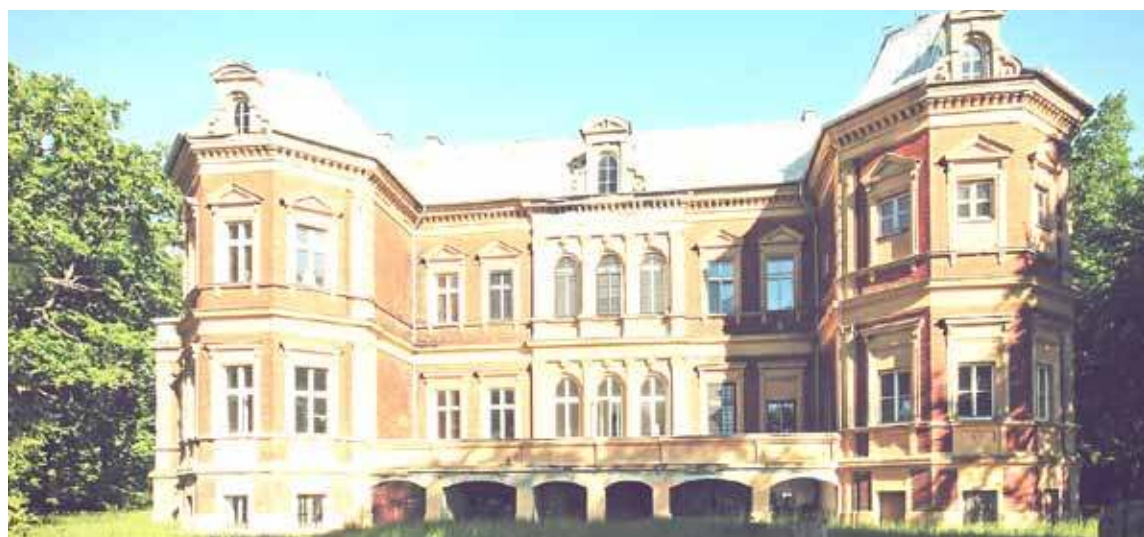
Jednym z zabytków, który przejdzie w tym roku prac jest Pałac w Karsznice.
