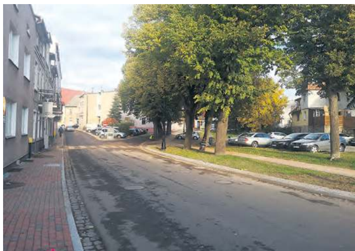
Przy ul. Zamkowej przebudowano też parking.
