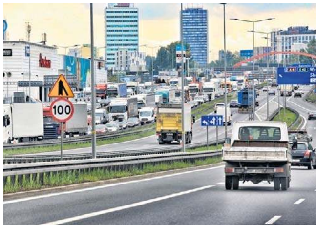
Autostrada A4 między ulicami Barbary a Wita Stwosza na kilkuset metrach ma zostać trwale zadaszona
