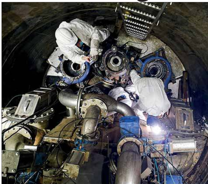
Ekipa naprawcza przy pracy
