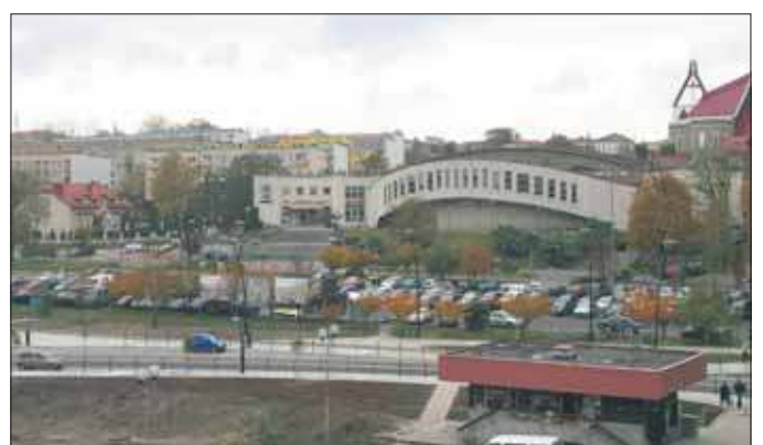
Po zakończeniu remontu hala zyska nową elewację
