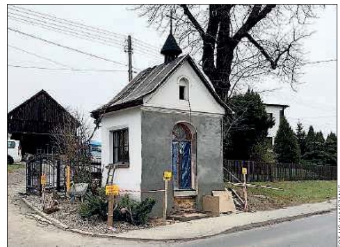
Remont kapliczki został zlecony przez KWK Jastrzębie-Bzie w ramach likwidacji szkód górniczych
