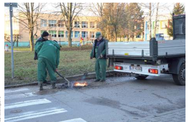
Przed świętami na ul. Przechodniej spotkaliśmy pracowników Gminnego Przedsiębiorstwa Gospodarki Komunalnej. Zaklejali dziurę masą bitumiczną
