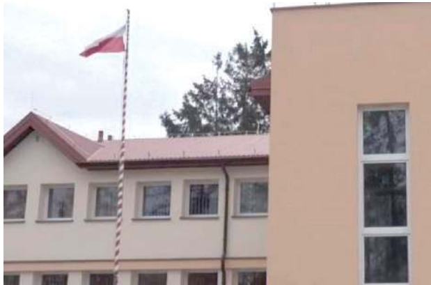
Budynek UG Dębowa Kłoda. Waldemar Wezgraj nie chciał odnosić się do tego, jak będą wyglądały szczegóły techniczne jego pracy, np. czy od godziny 8 do godz. 12 będzie sprawował funkcję zastępcy wójta, a od godz. 12 do godz. 16 – sekretarza
