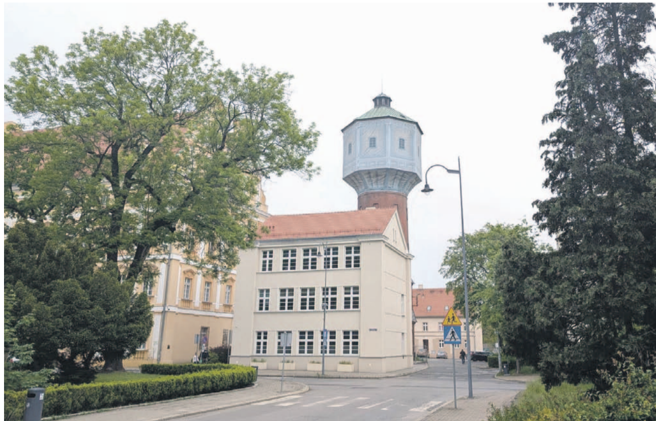
- Przez cały okres prowadzonych rozmów oraz analiz działaliśmy w dobrej wierze, z pełnym poszanowaniem historycznego charakteru obiektu oraz procedur związanych z ochroną konserwatorską - mówi obecny właściciel wieży ciśnień
