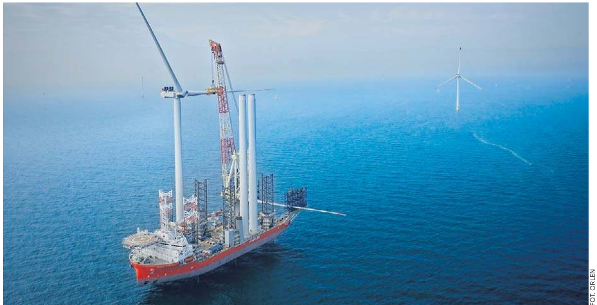
Stawianie siłowni wiatrowych na farmie Baltic Power
