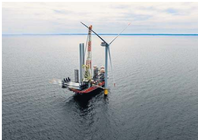
Osadzane monopali w dnie morskim umożliwia pływający dźwиг instalacyjny
