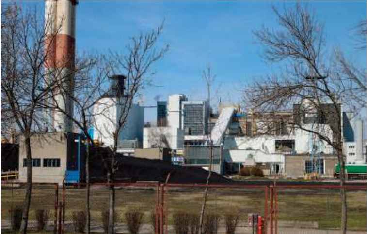
Elektrociepłownia „Wrotków” jest największym producentem ciepła i energii elektrycznej na Lubelszczyźnie. Wytwarzane w niej ciepło, dostarczane za pośrednictwem LPEC, pokrywa blisko 70% zapotrzebowania miejskiego systemu ciepłowniczego, a ilość produkowanej energii elektrycznej pokrywa zapotrzebowanie całego miasta i okolic. Jej moc elektryczna wynosi obecnie ok. 231 MWt, a moc cieplna – 592 MWt. Węglowe hałdy, jak również opalane nimi piece, znikną z terenu elektrociepłowni do końca 2023 roku
