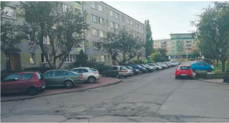
Na remont ul. Okrzei mieszkańcy będą musieli jeszcze poczekać
