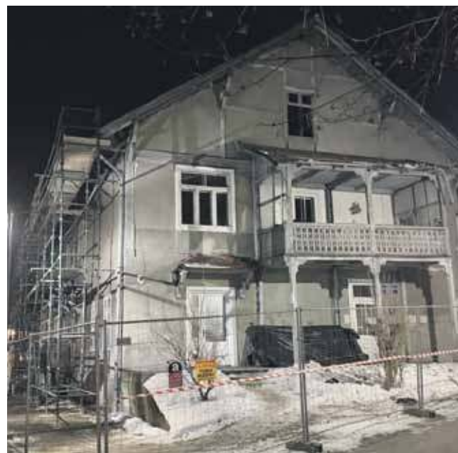
Remont Krzywonia już ruszył.
