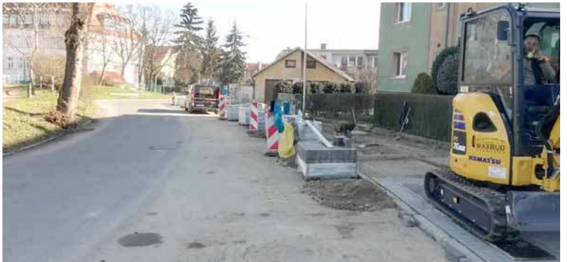
Trwa przebudowa chodnika przy pl. Majdanek
