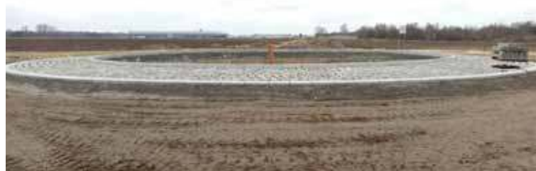
Wyraźnego kształtu nabrało nowe rondo, wybrukowane już dookoła
