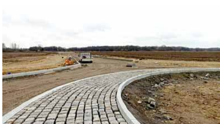
Widać rozdzielenie chodnika od jezdni, przy której położono krawężniki
