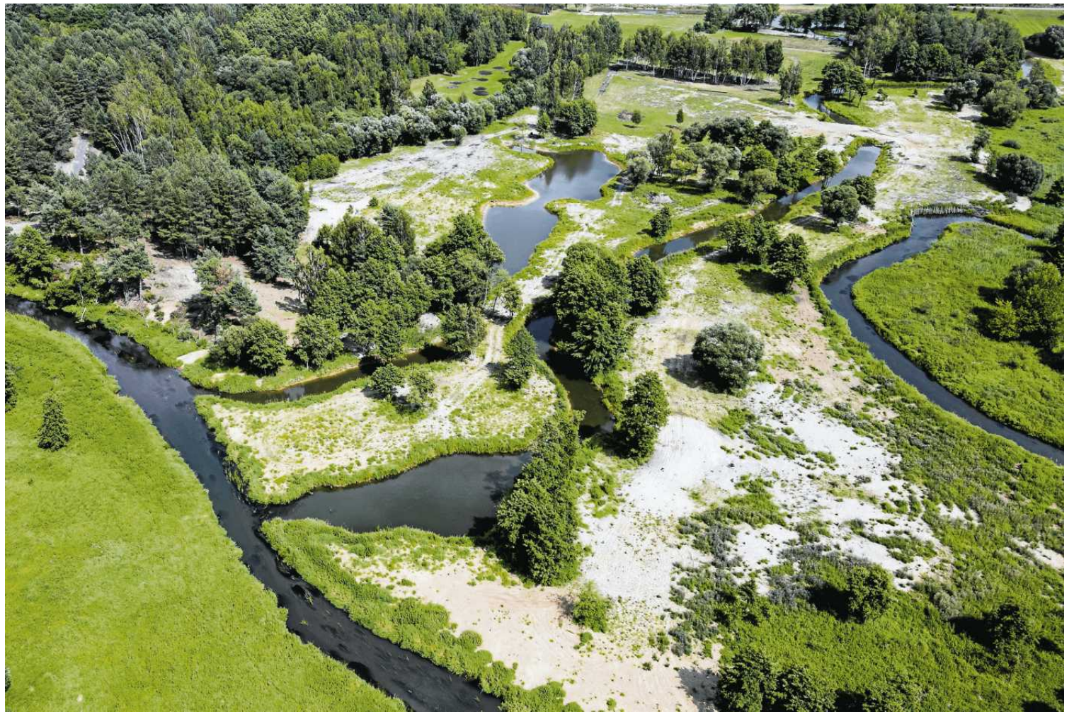
• W środku zdjęcia widać przekop do Drzewiczki i ślady po poważnych robotach ziemnych FOT. MARCIN KUCEWICZ / AGENCJA WYBORCZA.PL
