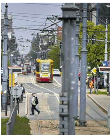
• Torowisko tramwajowe zostanie wymienione na odcinku Plac Reymonta - Plac Niepodległości. Łódź, 25 kwietnia 2025 roku
