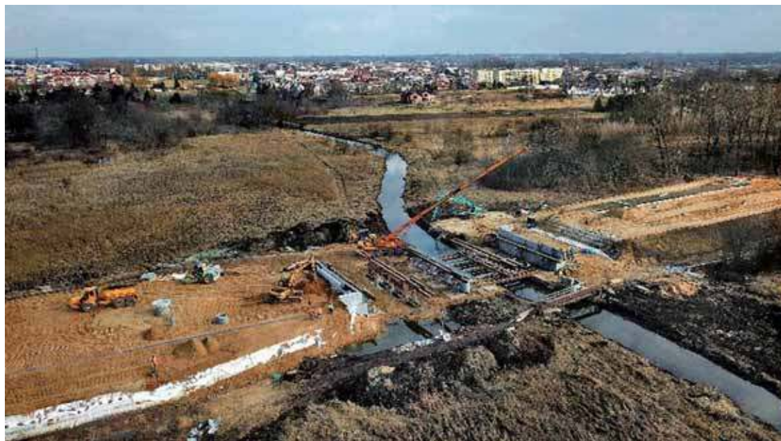
Fragment budowanej płońskiej obwodnicy z lotu ptaka
