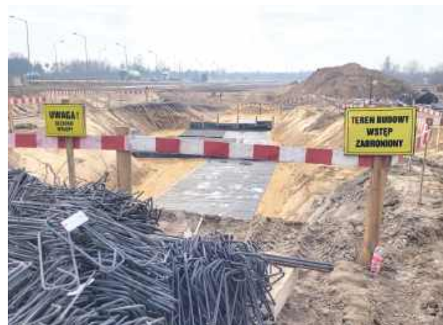
Wykopy pod fundamenty obiektów mostowych
