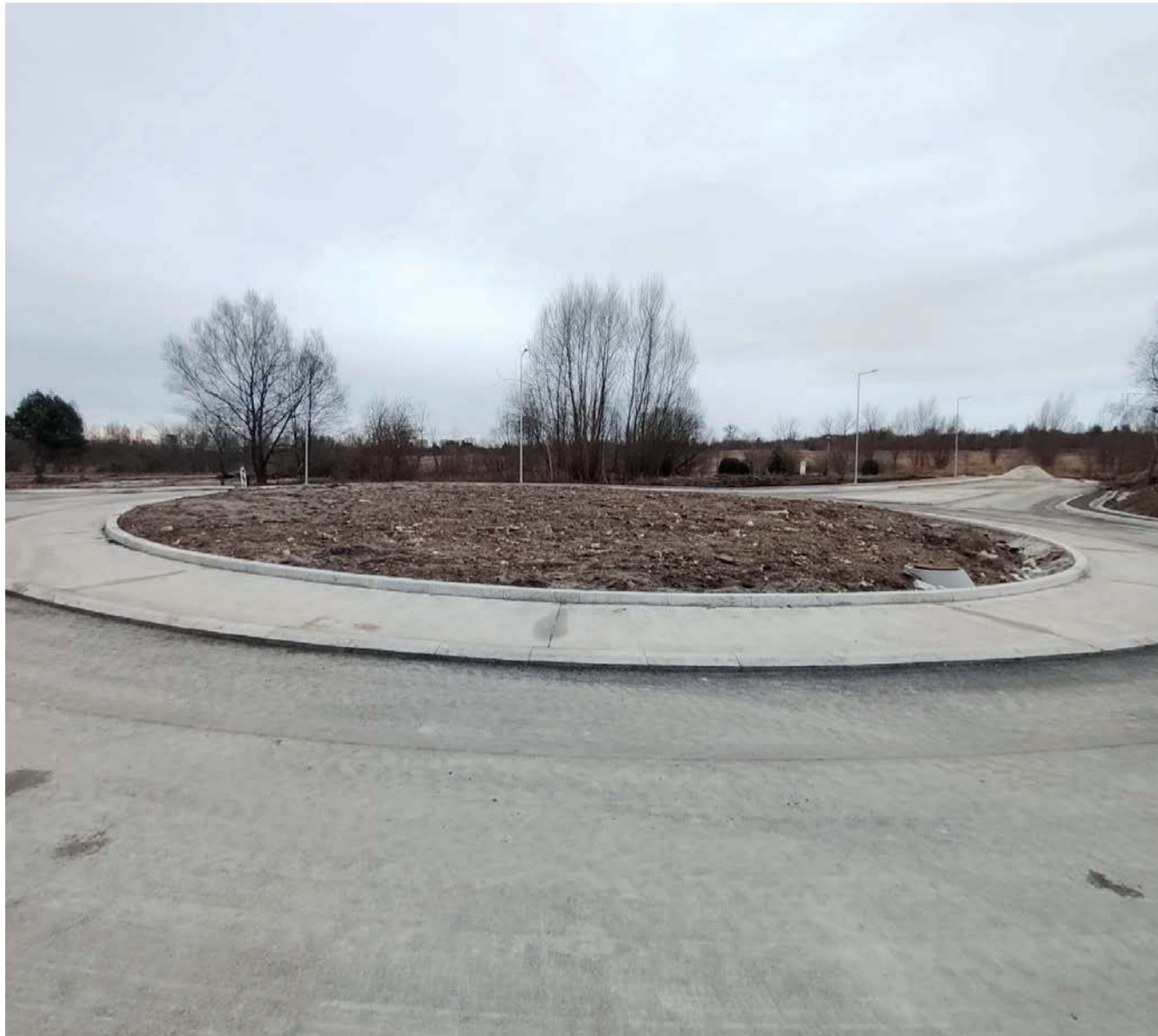
Największa kwota w budżecie Chrzanowa na 2026 r. została zaplanowana na budowę drogi przecinającej strefę gospodarczą przy A4. Pobiegnie od nowego ronda na Wodzińskiej, przez Działkową, do Węzła Balińskiego.
