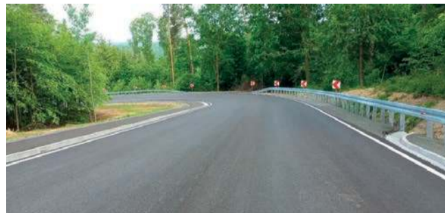
Przebudowane „serpentyń” łączące Alwernię i Grojec
