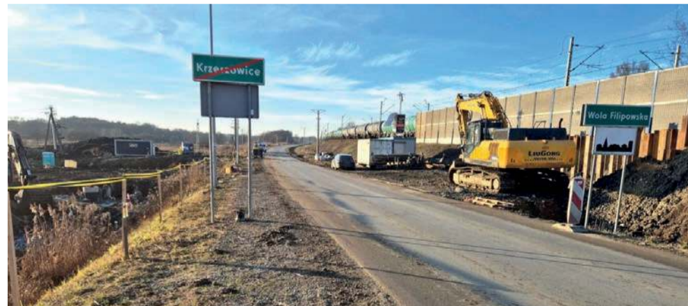
(e) Prace przy budowie nowego wiaduktu mają kosztować 15 mln zł
