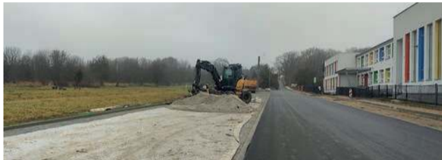
Nowy asfalt na ul. Dworskiej na osiedlu Kościelec w Chrzanowie
