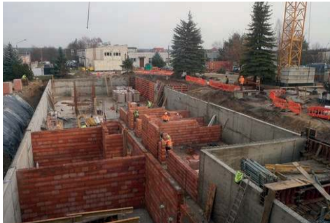
Trwa budowa Zakładu Opiekuńczo-Leczniczego przy Szpitalu Powiatowym w Chrzanowie
