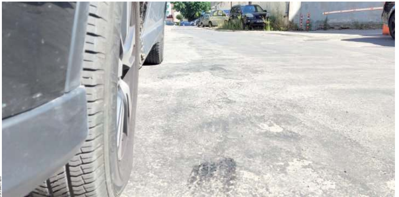
Nawierzchnia rzeczywiście jest niejednorodna. Widać fałdy i ślady bieżnika opon na nawierzchni, a to oznacza, że nowy dywanik nie jest odporny na wyższe temperatury
