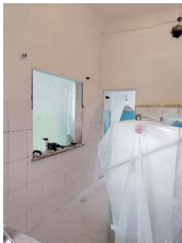
Dobiega końca remont kuchni
