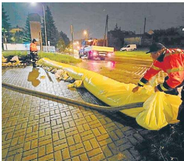
Nocna akcja rozkładania rękawa przeciwpowodziowego
