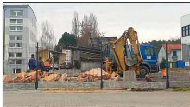
Tuż przed świętami brzydka betonowa konstrukcja została wyburzona.
